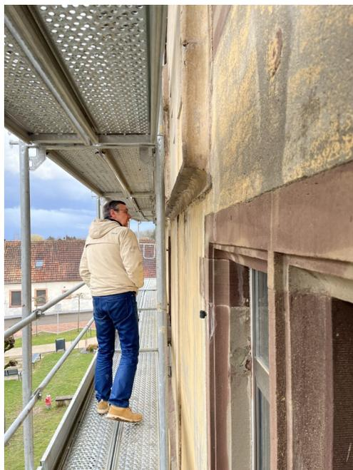
Des fissures, des corniches encore bien plus fragiles que ce que l'on pouvait imaginer, vue d'en bas ... ce qui inévitablement va engendrer un complément de travaux indispensables au niveau de la toiture pour
