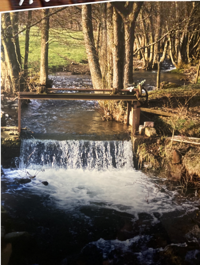
Fig. 3. Vanne dans le Rimbach permettant de dériver les eaux du ruisseau, par un canal d'amenée, vers le foulon (photo B.Risacher).
