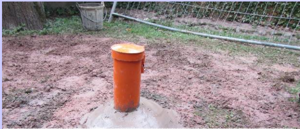
Chaque piézomètre est doté d'un numéro national. Il s'agit du code du dossier Banque du Sous-Sol (BSS)
