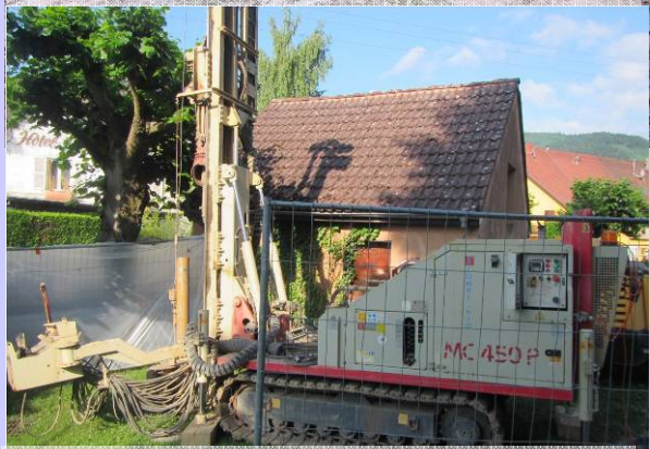
Machine de forage
